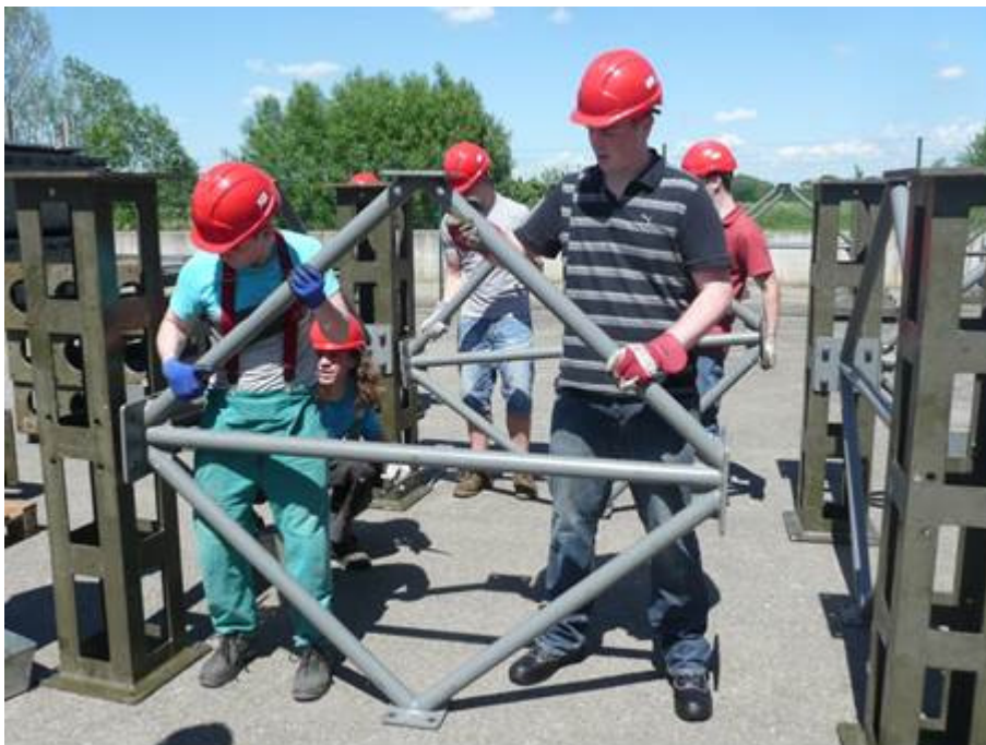
Předmontáž PIŽMO – pilíře železničních mostů
