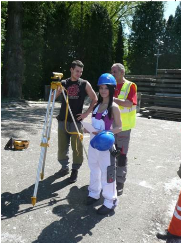
Vytýčení správné výšky podpěr pro ŽM 16.
