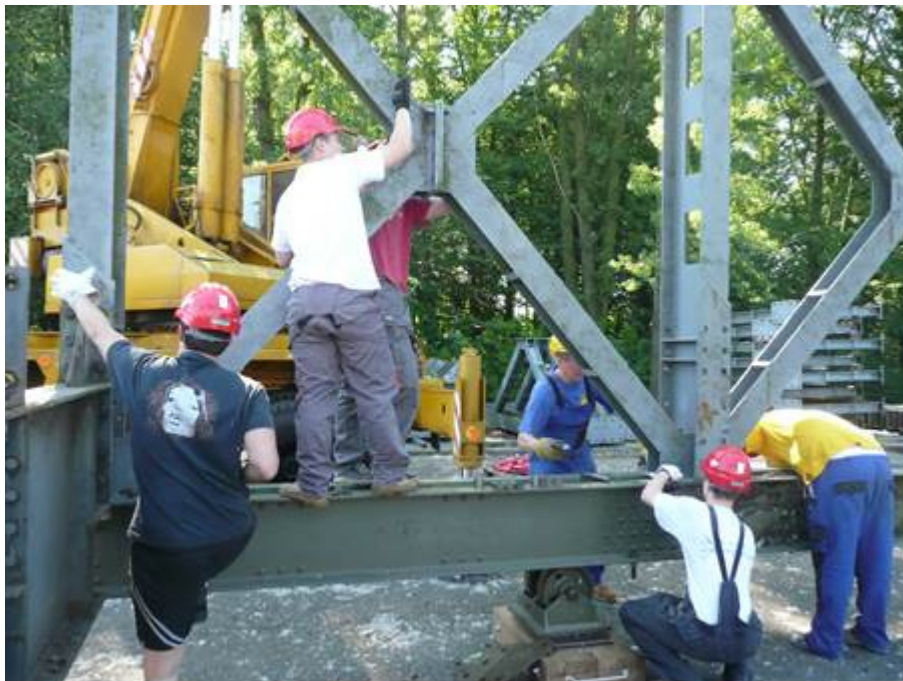
Práce na ŽM 16
