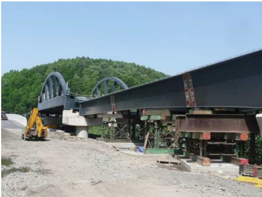
Pohled na mostní konstrukce průjezdu železničním uzlem Ústí nad Orlicí
