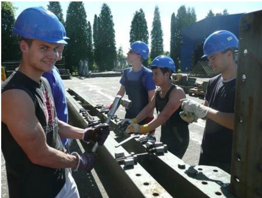
Montáž šroubů na mostě ŽM 16
